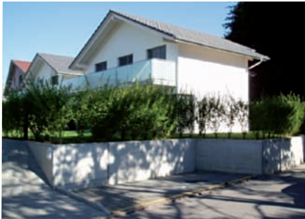
Abb. 29: Umgesetzte Objektschutzmassnahmen beim Neubau: Bauen auf Aufschüttung (links) und Sockelbauweise (rechts).
