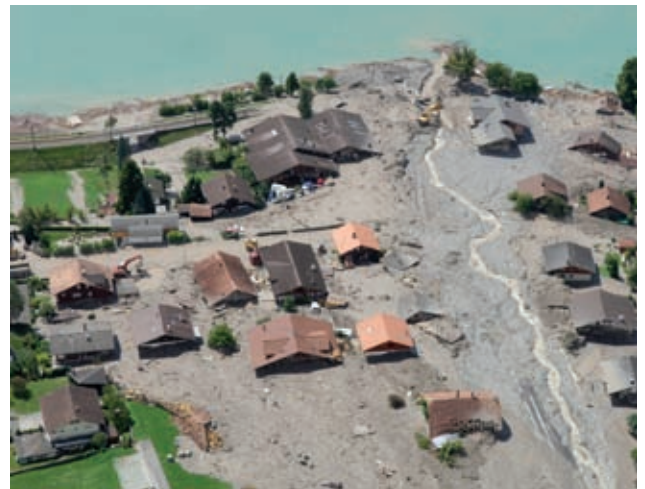
Abb 10: Murgang in Brienz (BE) nach dem Starkniederschlagsereignis im August 2005. © Schweizer Luftwaffe
